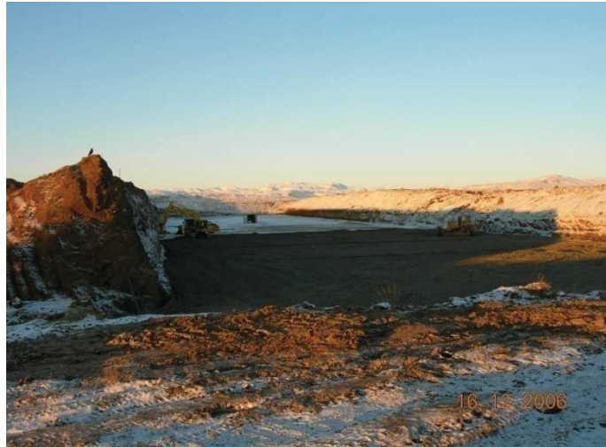
Urðunarrein (Sorpstöð Suðurlands)
